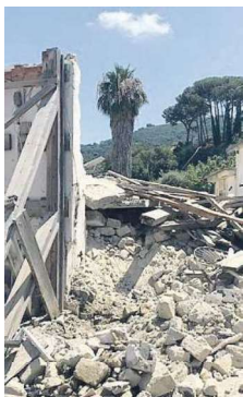
LE RUSPE Demolizione a Ischia
